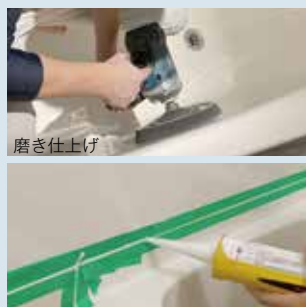
コーキング打設で防水処理
