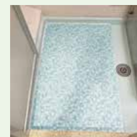
床シートを貼って施工完了
