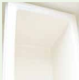
仕上げの吹き付け塗装で補修完了
