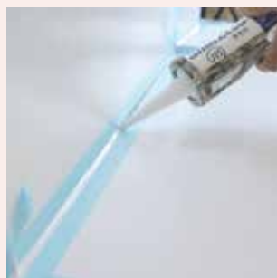
コーキング打設で防水処理
