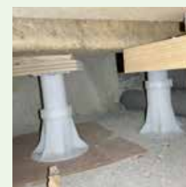
ブラ束を設置して基礎を作り補強
