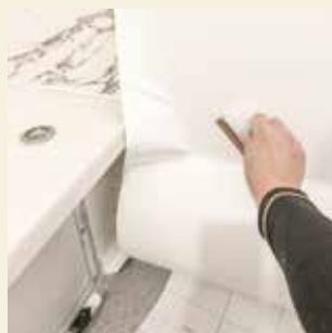
空気を抜きながら圧着
