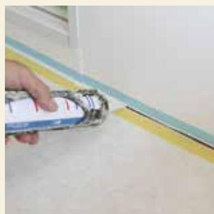
床材専用コーキングで防水処理
