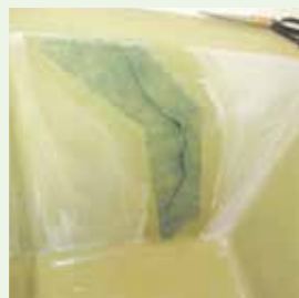
FRP ライニング層の積層
