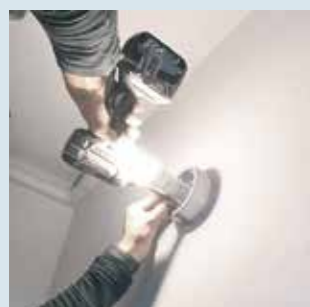
機器取り外し
