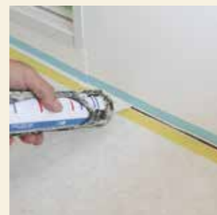
床材専用コーキングで防水処理
