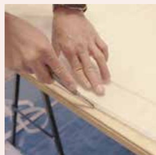
採寸しながら現地でカッターにてカット
