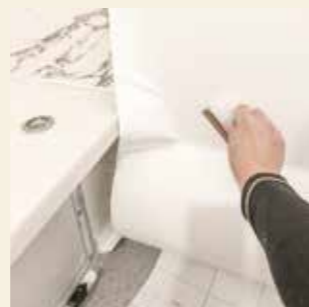
空気を抜きながら圧着
