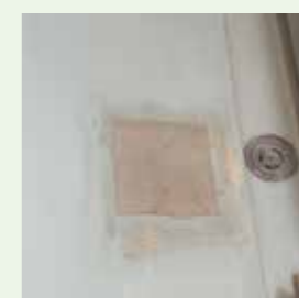
FRP ライニングで防水処理
