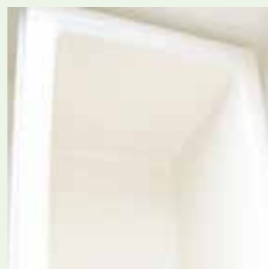
仕上げの吹き付け塗装で補修完了
