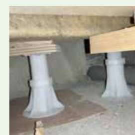
ブラ束を設置して基礎を作り補強
