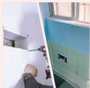
機器取り外し
