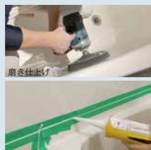
コーキング打設で防水処理
