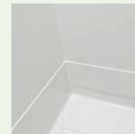
防水処理で施工完了
