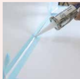
コーキング打設で防水処理
