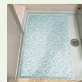
床シートを貼って施工完了
