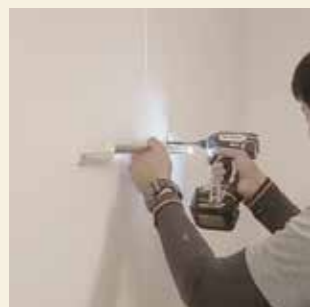
機器取り外し
