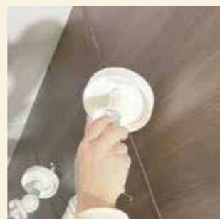
設備機器復旧
