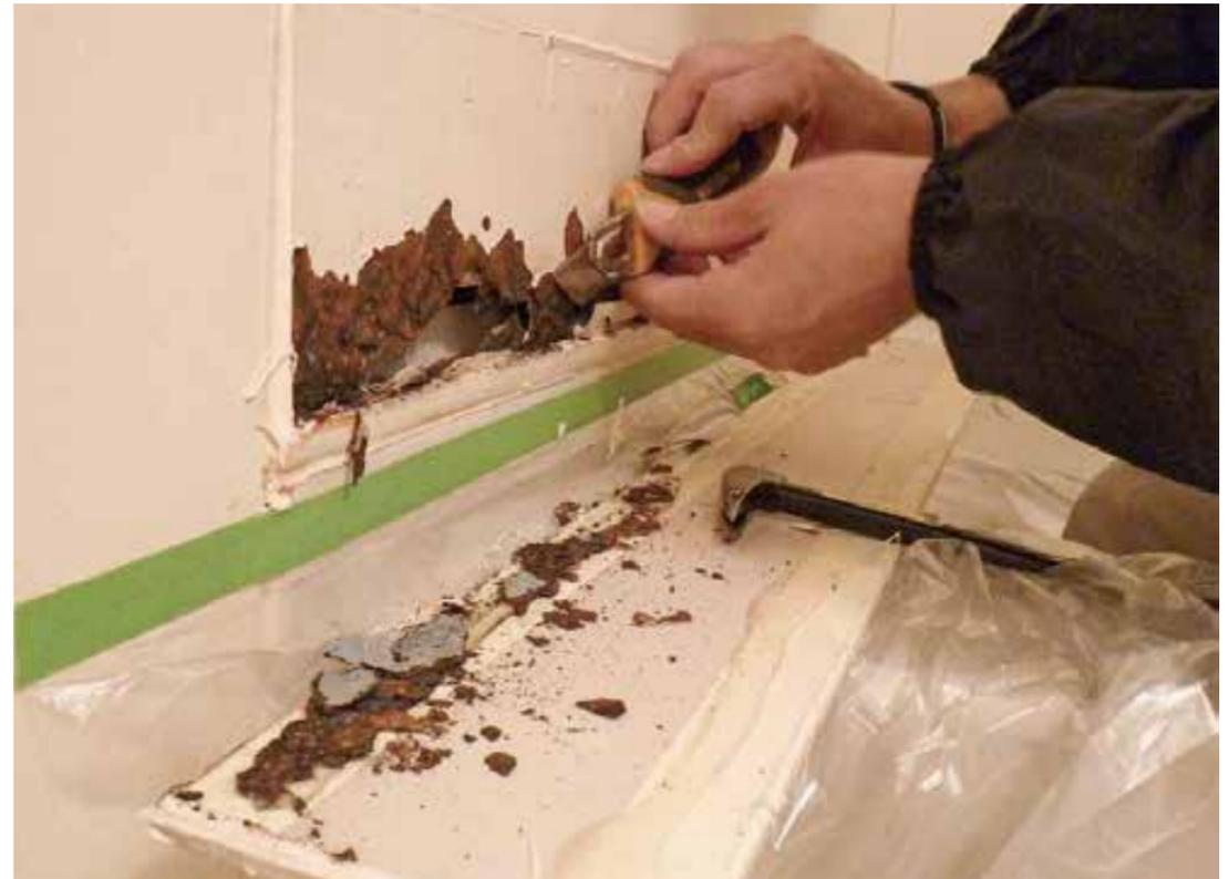
ユニットバスの壁によく使われている「塩ビ鋼板」は、芯材に鋼板 (鉄板) を使用しており、鋼板に水が触れるとサビでふくれが生じ、劣化します。鋼板壁サビ補修とは、このようなサビによる問題が生じている箇所のみ施工するため、より低コストかつ短納期の補修方法です。仕上げにはお好みの化粧シートをお選びいただけますので、浴室デザインのワンポイントとしてもお使いいただけます。『ハリフォーム』『ヌリフォーム』を行う前の、下地補修としても使用します。
