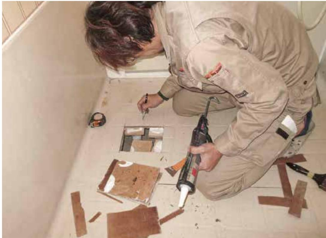
上に乗るとべこべこ凹んだり、ぎしぎし音が鳴るようなたわんだ床を補修します。たわんだ箇所を開口し、束等で補強を施すことで床のたわみを解消します。開口部は補強した後にしっかりと防水処理を施しますので、水漏れの心配はありません。
