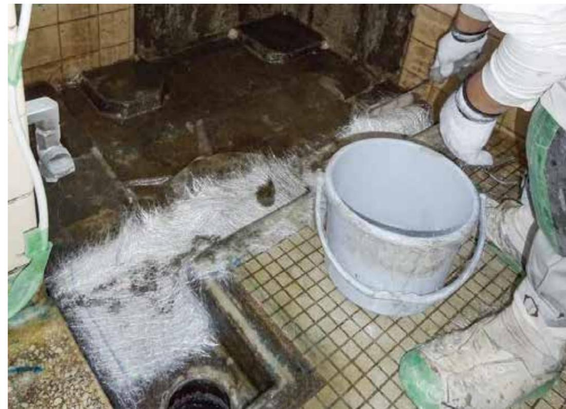
浴室内の既存の床全体に防水工事を行います。浴室の劣化で問題となる、防水層の老朽化による漏水被害対策として、弊社ではFRP防水施工を行っております。FRP防水施工の良いところは、既存の浴室を壊さずに施工するため、短工期・低コスト。平面はもちろん、曲面や角にも施工できるため、浴室の形状を選びません。
